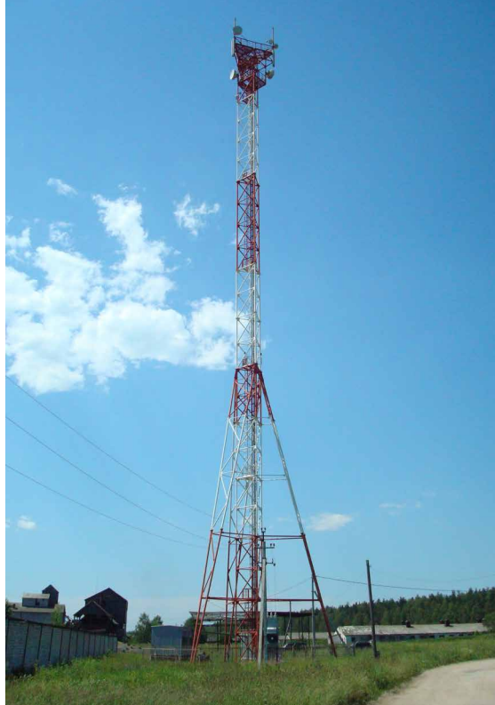
◀ 83-метровая стальная башня, спроектированная командой кафедры теории сооружений и технической механики по заказу компании «ВымпелКом». Шесть таких башен стоят во Владимирской области
