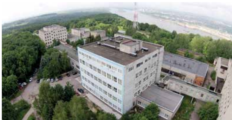
▲ Здание Института металлоорганической химии им. Г.А. Разуваева РАН на ул. Тропинина
